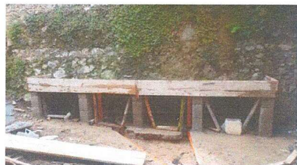
Foto 4: 75 porciento de avance de lavamanos exterior
