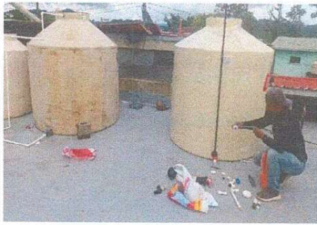
Foto1: Estructurando la red de agua potable en los tinacos para mejorar el servicio.
