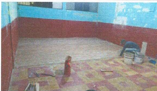
Foto 5: Colocación de pizo en las aulas.
